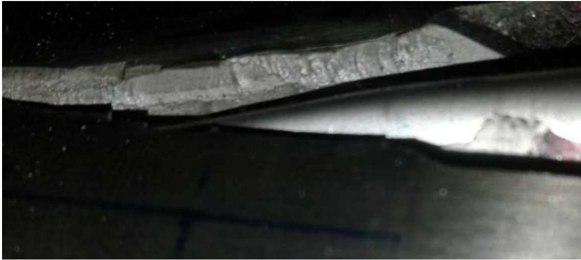
figura 60. Foto una de las fisuras. A lo largo de la fisura se pueden apreciar zonas con grandes deformaciones plásticas,
