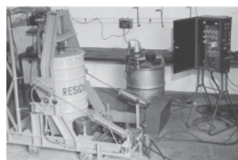
Compactación de residuos radiactivos de baja actividad Área de Gestión Ezeiza Pcia. de Buenos Aires
