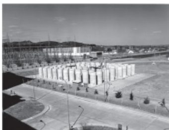
Almacenamiento temporario en silos de elementos combustibles gastados de la Central Nuclear Embalse - Pcia. de Córdoba
