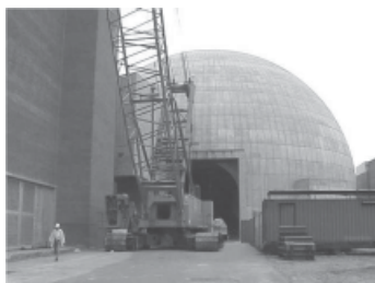
Área Energía Nuclear: Central Nuclear Atucha II (en construcción) - Entrada al edificio del reactor
