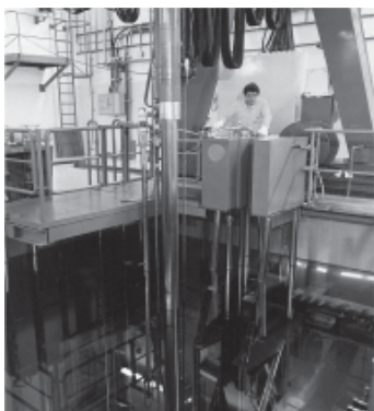
Pileta de almacenamiento temporario de elementos combustibles gastados Central Nuclear Embalse Pcia. de Córdoba
