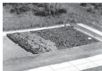
Trinchera para almacenamiento temporario de residuos de baja actividad – Área de Gestión Ezeiza Pcia. de Buenos Aires
