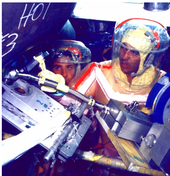
Técnicos del Departamento Servicios Para Centrales efectuando tareas de mantenimiento durante una parada.
