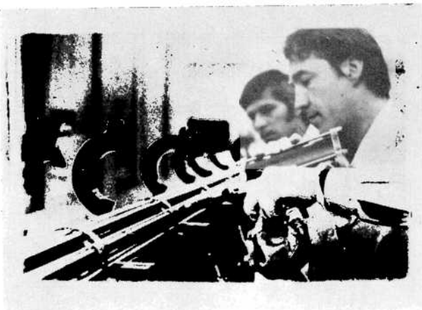
FIGURA 9: Montaje del Elemento Combustible Atucha.
