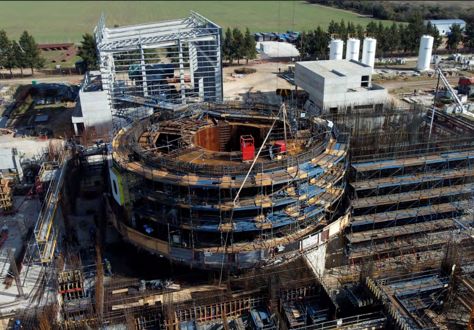
Avance de obra CAREM Agosto de 2022.
