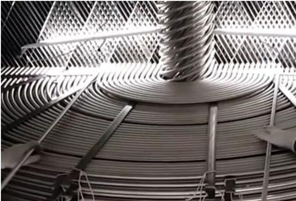
Figura 14: Proceso de entubado de los nuevos GVs de CNE; en el fondo se observan las TSPs del tipo caja de huevos , donde se insertan los tubos del GV. [27]
