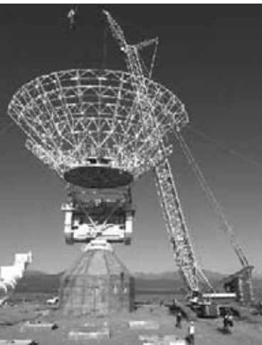
Proyecto DSA-3 Antena de 35 mts. de diámetro de disco en construcción cerca de Malargüe Pcia. de Mendoza
