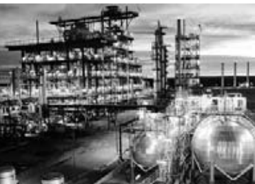
Planta Industrial de Agua Pesada de ENSI S.E. - Arroyito Pcia. de Neuquén
