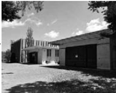
Instalaciones del Área de Gestión Ezeiza Centro Atómico Ezeiza
