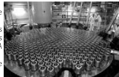
Central Nuclear Atucha II (en construcción) Montaje del núcleo del reactor
