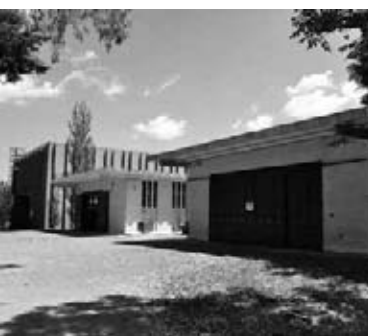
Instalaciones del Área de Gestión Ezeiza Centro Atómico Ezeiza Pcia. de Buenos Aires
