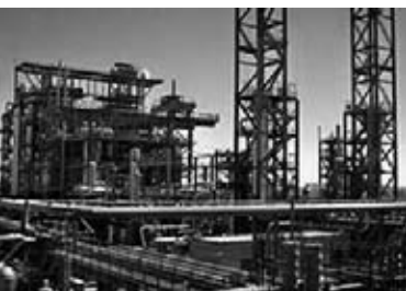
Planta Industrial de Agua Pesada de ENSI S.E.
