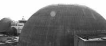
Central Nuclear Atucha II (en construcción) Cúpula del recinto de contención
