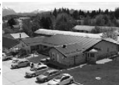
Proyecto CAREM Edificio de Ingeniería Centro Atómico Bariloche
