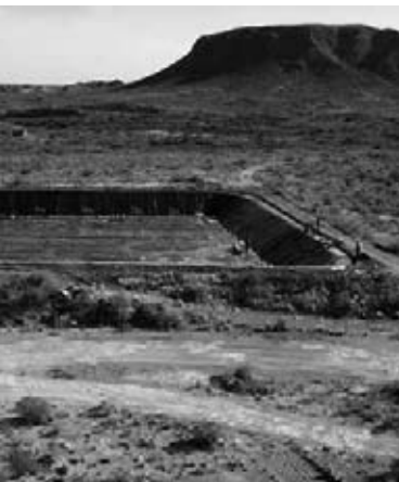
Reparación del dique pulmón de efluentes ácidos Complejo Minero Fabril San Rafael Pcia. de Mendoza
