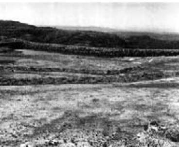
Proyecto de restitución ambiental de la Minería del Uranio (PRAMU) Diques de contención Ex -Yacimiento Minero Los Gigantes Pcia. de Córdoba
