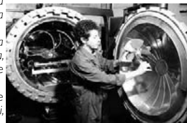
Autoclaves utilizados en el sector de producción de materiales compuestos INVAP S.E.
