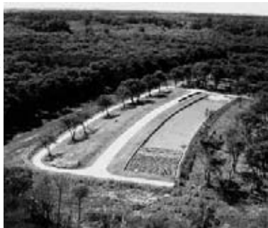
Trinchera para almacenamiento temporario de residuos de baja actividad Área de Gestión Ezeiza
