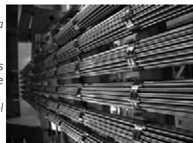
Central Nuclear Atucha II (en construcción) Elementos combustibles colgados para carga
