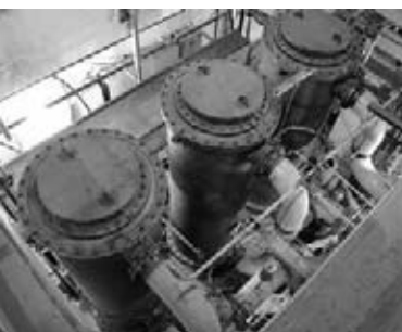
Central Nuclear Atucha II (en construcción) Bombas de aceite
