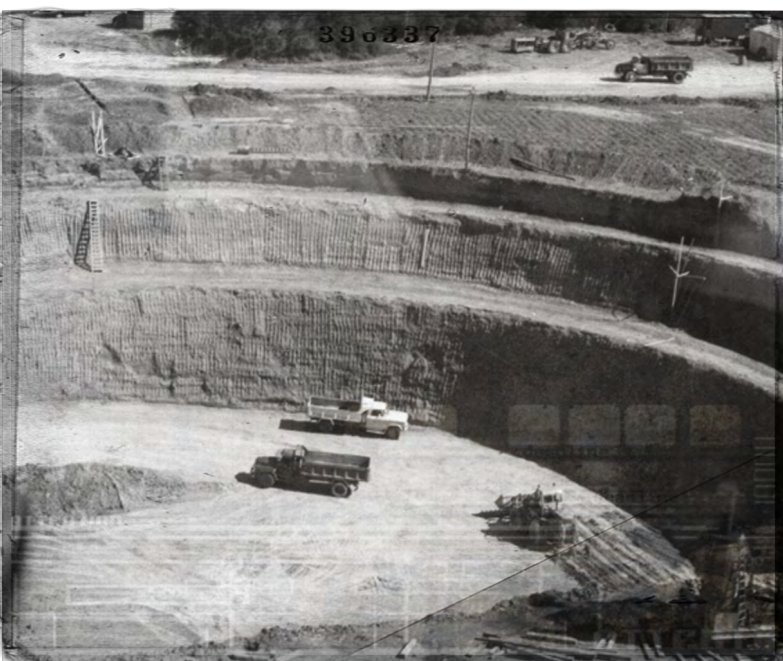
Excavación para la base del edificio del reactor.
