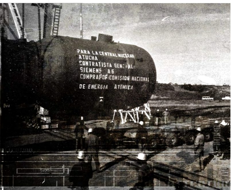
Llegada a la Central Nuclear Atucha I del generador de vapor con ayuda de una grúa y un camión con acoplado de 10 ejes.
