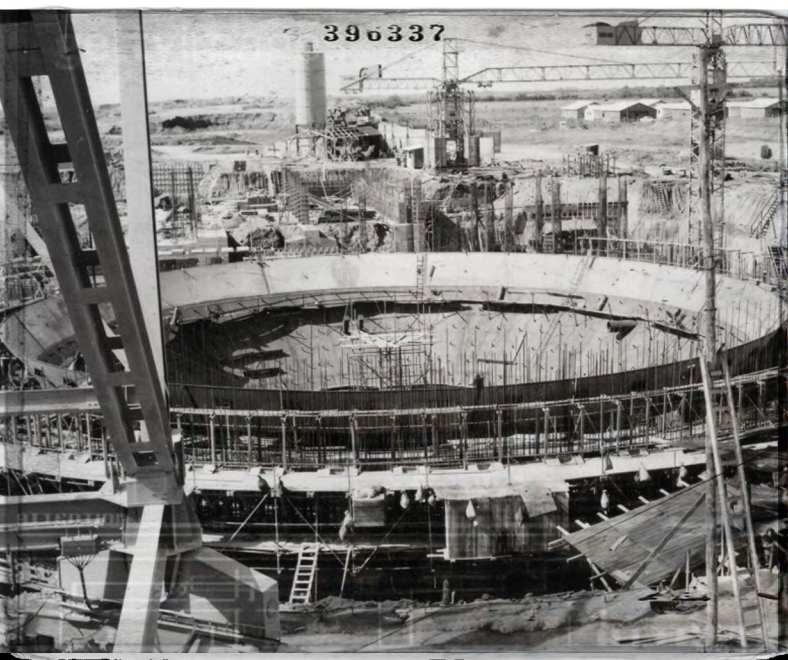
Vista de los avances en la construcción del edificio del reactor de la Central Nuclear Atucha I.
