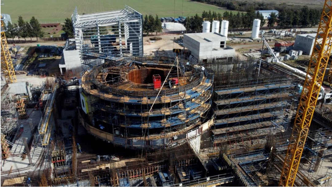
Figura 3: Proyecto CAREM25, vista aérea de la obra civil en proceso de construcción. Noviembre de 2022. Fuente: Gerencia de Área CAREM.
