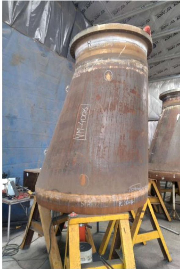
Figura 30: Troncocónica en proceso de amolado, el mismo se efectuó en cordones de soldadura interiores.
