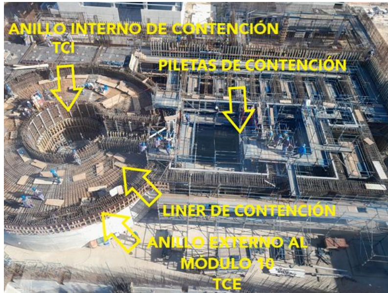
Figura 18: Vista aérea del reactor CAREM en construcción a la izquierda y las piscinas de contención a la derecha. Fuente: Gerencia de Área CAREM.
