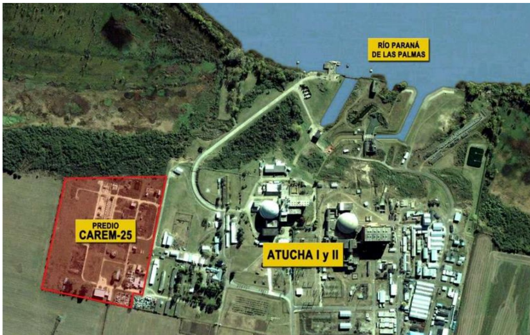
Figura 2: Vista aérea del predio en Lima, Zárate. A la derecha, se observan las instalaciones de Atucha I y Atucha II, mientras que a la izquierda, en la zona resaltada en rojo, se encuentra el sitio donde se está construyendo el reactor nuclear CAREM25. Fuente: Gerencia de Área CAREM.
