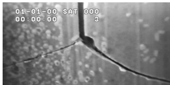
Figura 19: Imagen de inspección del C.R. de la posición N10.
