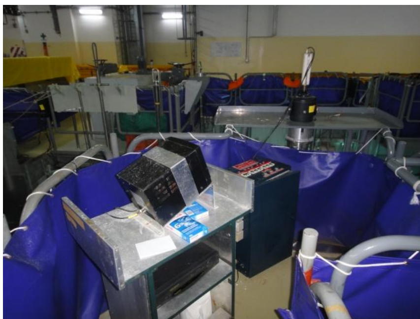
Figura 23: Foto del sistema implementado en el periscopio de casa de piletas 2.
