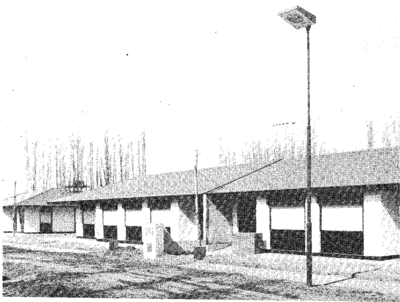
Grupo de viviendas, Barrio Plottier, para el personal de la Planta
