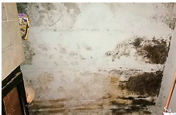
Proliferación de organismos biológicos en cielorraso de baño, en vivienda unifamiliar. (Fuente: Trabajos prácticos 2020 de la materia PCMRHa - FADU - UBA)
