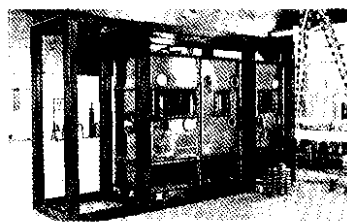
Proyecto LFR: Laboratorio de Facilidades Radioquímicas Estructura metálica porta blindaje y recintos alfa estancos de celdas Centro Atómico Ezeiza
