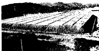
Producción de concentrado de uranio. Piletas de lixiviación
