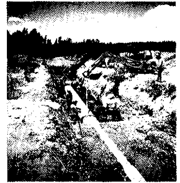
Proyecto Restitución ambiental de la minería del uranio: Sistema de drenaje de aguas superficiales y subterráneas – ex Complejo Minero Fabril Malargüe
