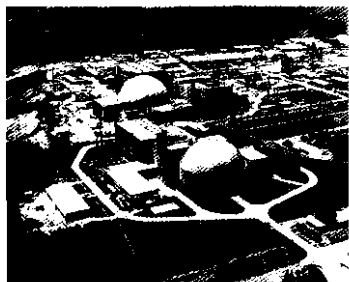
Generación de energía: Central Nuclear Atucha I y Central Nuclear Atucha II (en construcción) - Pcia de Buenos Aires
