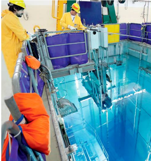
PILETA CON COMBUSTIBLES NUCLEARES GASTADOS EN AGUA
