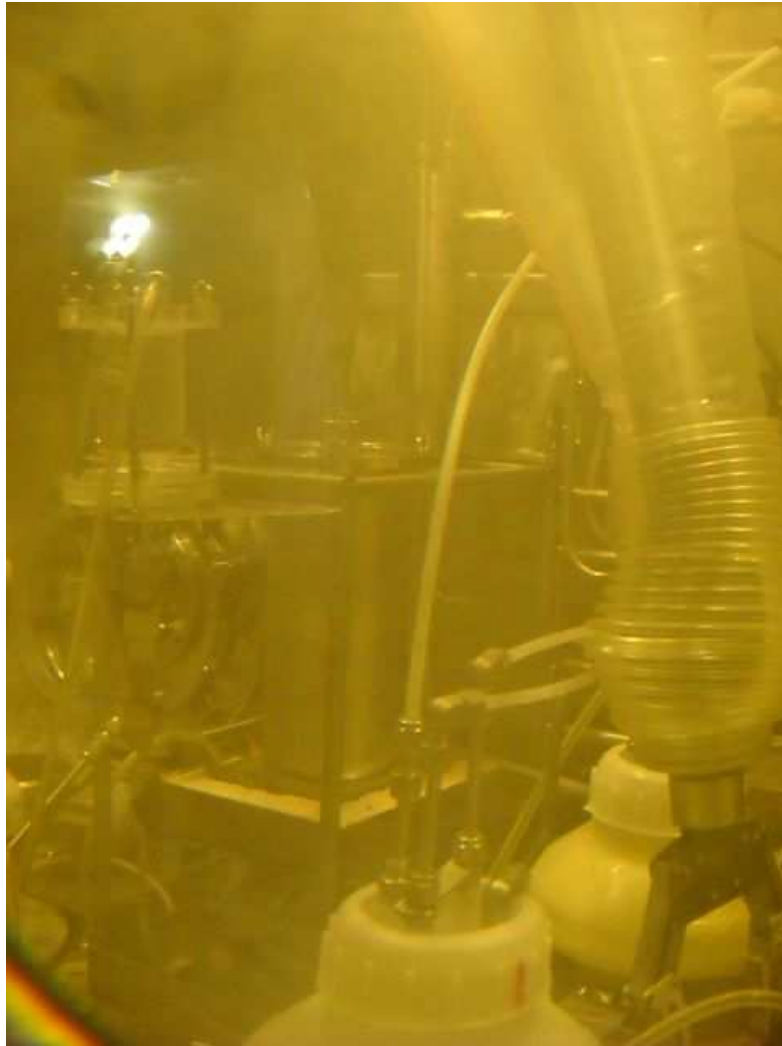
Foto 5.2 – Interior de celdas. En el centro de la imagen se puede ver el disolventor de acero inoxidable y su condensador en la parte superior.
