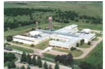
Combustibles Nucleares Argentinos S.A.(CONUAR S.A.) Ezeiza – Provincia de Buenos Aires
