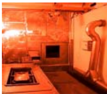
Proyecto LAPEP Interior de celda blindada
