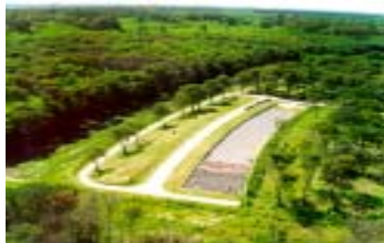
Repositorio de residuos de baja actividad - Área de Gestión Ezeiza
