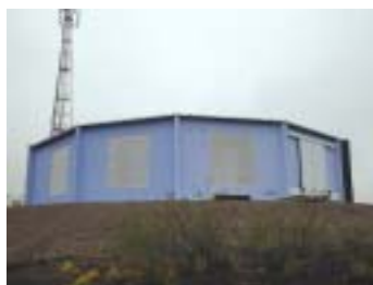
Proyecto Internacional Pierre Auger - Edificio para seis telescopios en Cerro Los Leones y torre de comunicaciones
