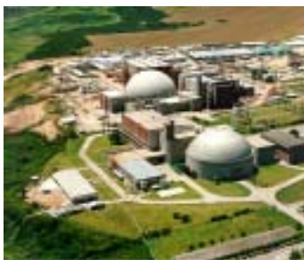
Proyecto KP Centrales Nucleares Atucha I y II (en construcción)
