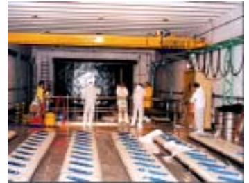
Pileta de almacenamiento temporario de combustible gastado de reactores de investigación Área de Gestión Ezeiza
