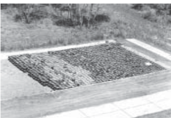
Gestión de residuos radiactivos: Repositorio para almacenamiento de residuos de baja actividad. Área de Gestión Ezeiza
