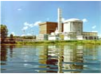
Generación de energía: Central Nuclear Embalse,
