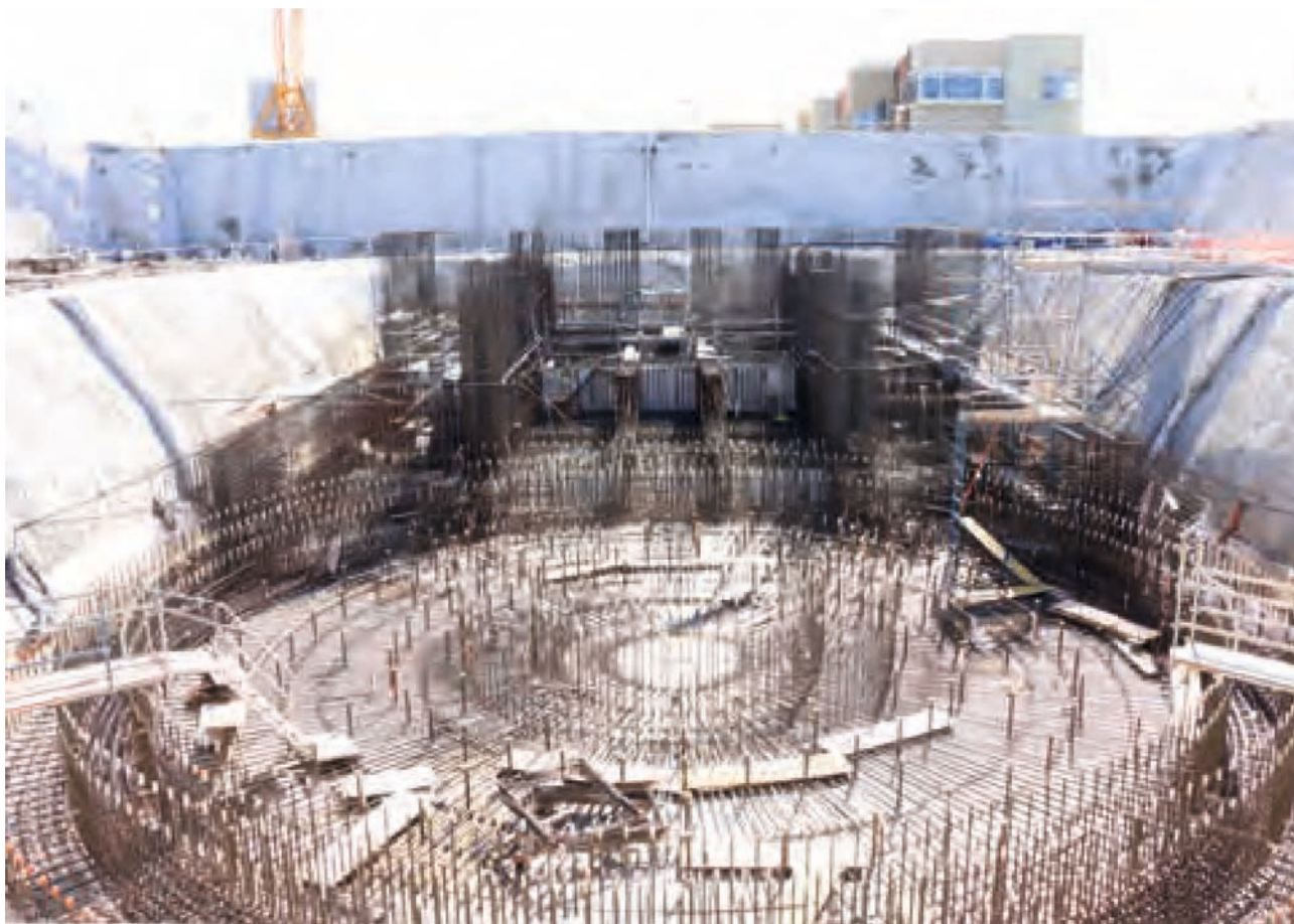
Hormigonado de la CN CAREM-25
