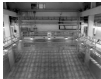
Piletas para almacenamiento temporario de elementos combustibles gastados de la Central Nuclear Atucha I
