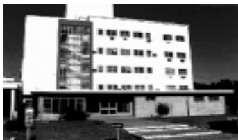
Proyecto Radioisótopos de reactor: Edificio del reactor de producción de radioisótopos RA 3 Centro Atómico Ezeiza
