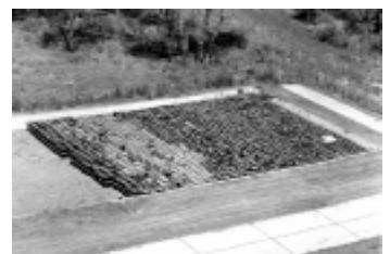
Trinchera para almacenamiento temporario de residuos de baja actividad. - Área de Gestión Ezeiza
