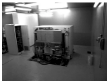
Bunker del ciclotrón de producción - Centro Atómico Ezeiza
