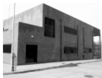
Proyecto Antena radar de apertura sintética: Facilidad de fabricación. Edificio ARAS Centro Atómico Constituyentes
