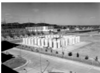
Almacenamiento temporario en silos de elementos combustibles gastados de la Central Nuclear Embalse
