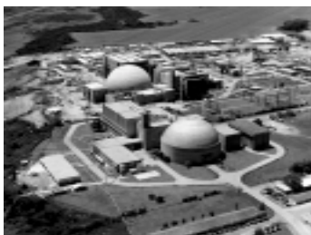
Proyecto Atucha II: Central Nuclear Atucha II (en construcción). Lima - provincia de Buenos Aires
