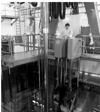
Pileta de almacenamiento temporario de elementos combustibles gastados de la Central Nuclear Embalse
