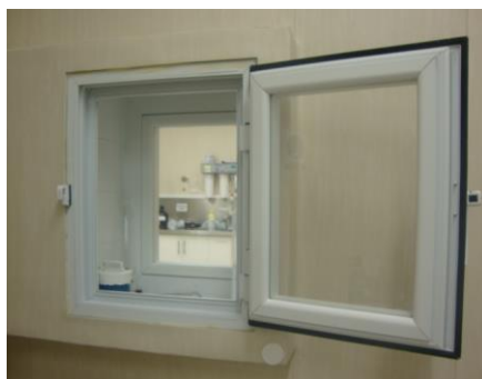
Figura 2. Recinto de doble ventana para la salida de material del laboratorio de producción de radiofármacos PET, FCDN.
