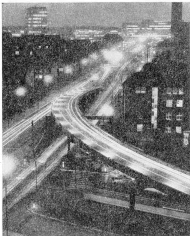
Figura 3 — Carretera elevada. Cruce sobre nivel portátil, de acero, en Essen. Vista de noche. Dos vías de tránsito. Largo 240 m., Curva en ángulo recto con radio de 150 m. pendientes de 6 y 7%. Peso en acero 517 t. Foto Krupp.
