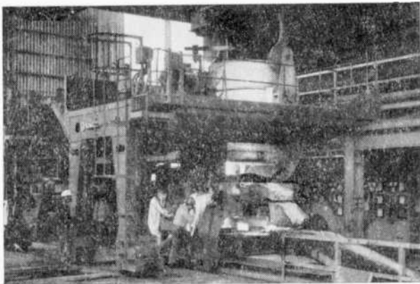
Fig. N° 1-A — Tundish en la operación de colar recibiendo metal de la cuchara.
