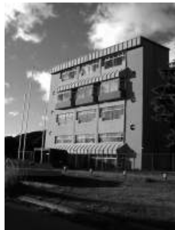
Edificio del reactor de investigación RA-6 Centro Atómico Bariloche
