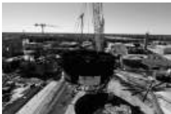
Proyecto CAREM – Colocación de un “liner” (revestimiento interno de acero del blindaje de contención)
