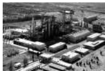
Planta Industrial de Agua Pesada ENSI S.E.- Arroyito Provincia del Neuquén
