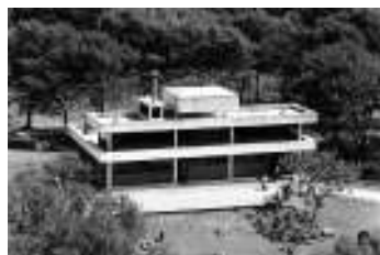
Gestión de residuos radiactivos Edificio de acondicionamiento Área de Gestión Ezeiza
