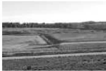
Proyecto Restitución Ambiental de la Minería del Uranio (PRAMU) Trabajos de restitución en el Ex - Complejo Minero Fabril Malargüe
