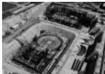
Proyecto CAREM Cimientos del edificio del reactor
