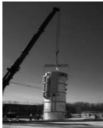
Reactor de investigación multipropósito RA-10 (en construcción) Instalación de la pileta Centro Atómico Ezeiza
