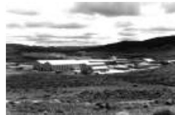
Planta Piloto de Enriquecimiento de Uranio Complejo Tecnológico Pilcaniyeu Provincia del Neuquén
