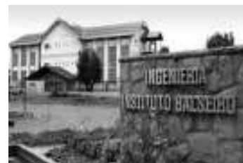
Edificio de Ingeniería del Instituto Balseiro – Centro Atómico Bariloche Provincia de Río Negro
