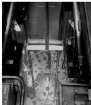
Facilidad de Almacenamiento de Combustibles Irradiados de Reactores de Investigación (FACIRI) Centro Atómico Ezeiza Almacenamiento de un elemento combustible irradiado en la canasta
