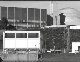
Central Nuclear Juan Domingo Perón (ex Atucha I) Vista desde la toma de agua Lima - Pcia. de Buenos Aires
