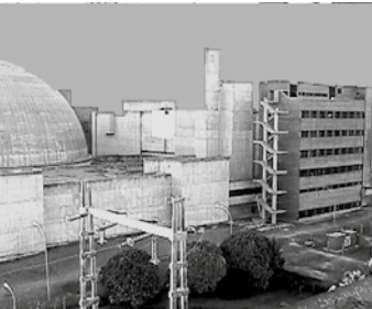
Central Nuclear Néstor Kirchner (ex Atucha II) Edificio de la Administración
