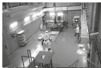
Pileta de almacenamiento de la Facilidad de Almacenamiento para Combustibles Irradiados de Reactores de Investigación (FACIRI) Centro Atómico Ezeiza - Pcia. de Buenos Aires
