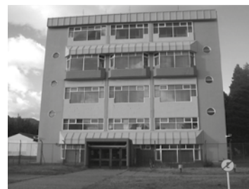
Edificio del reactor de investigación RA-6 Centro Atómico Bariloche
