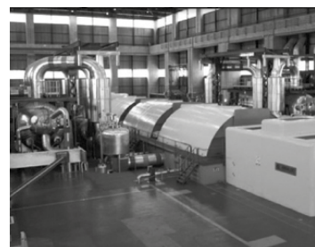
Central Nuclear Embalse Turbogenerador
