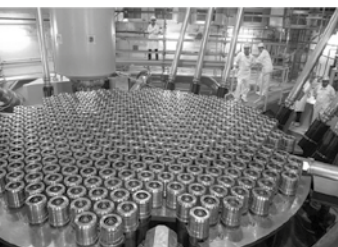
Central Nuclear Néstor Kirchner (ex Atucha II) Canales para los elementos combustible y barras de control
