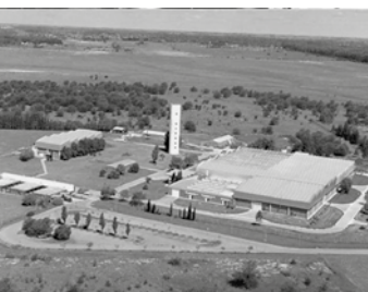
Fábrica de Aleaciones Especiales S.A. (FAE S.A.) Centro Atómico Ezeiza
