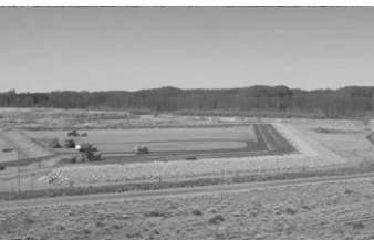
PRAMU – Trabajos de restitución en el Ex - Complejo Minero Fabril Malargüe Pcia. de Mendoza
