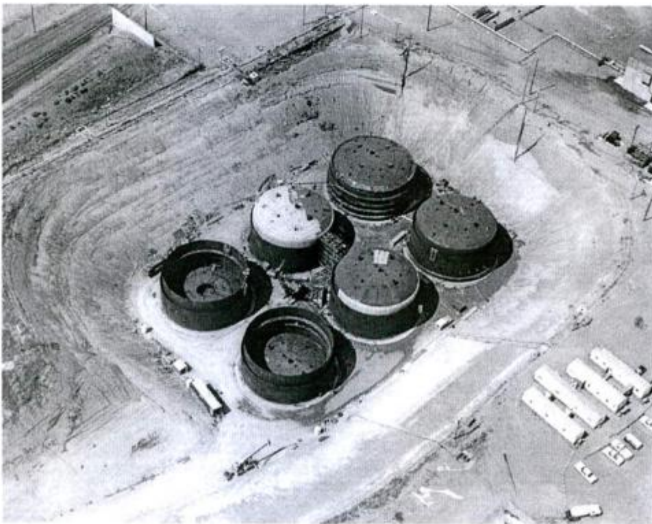
Figura I.1. Tanques de Doble Pared en construcción, Hanford 1980[6].
