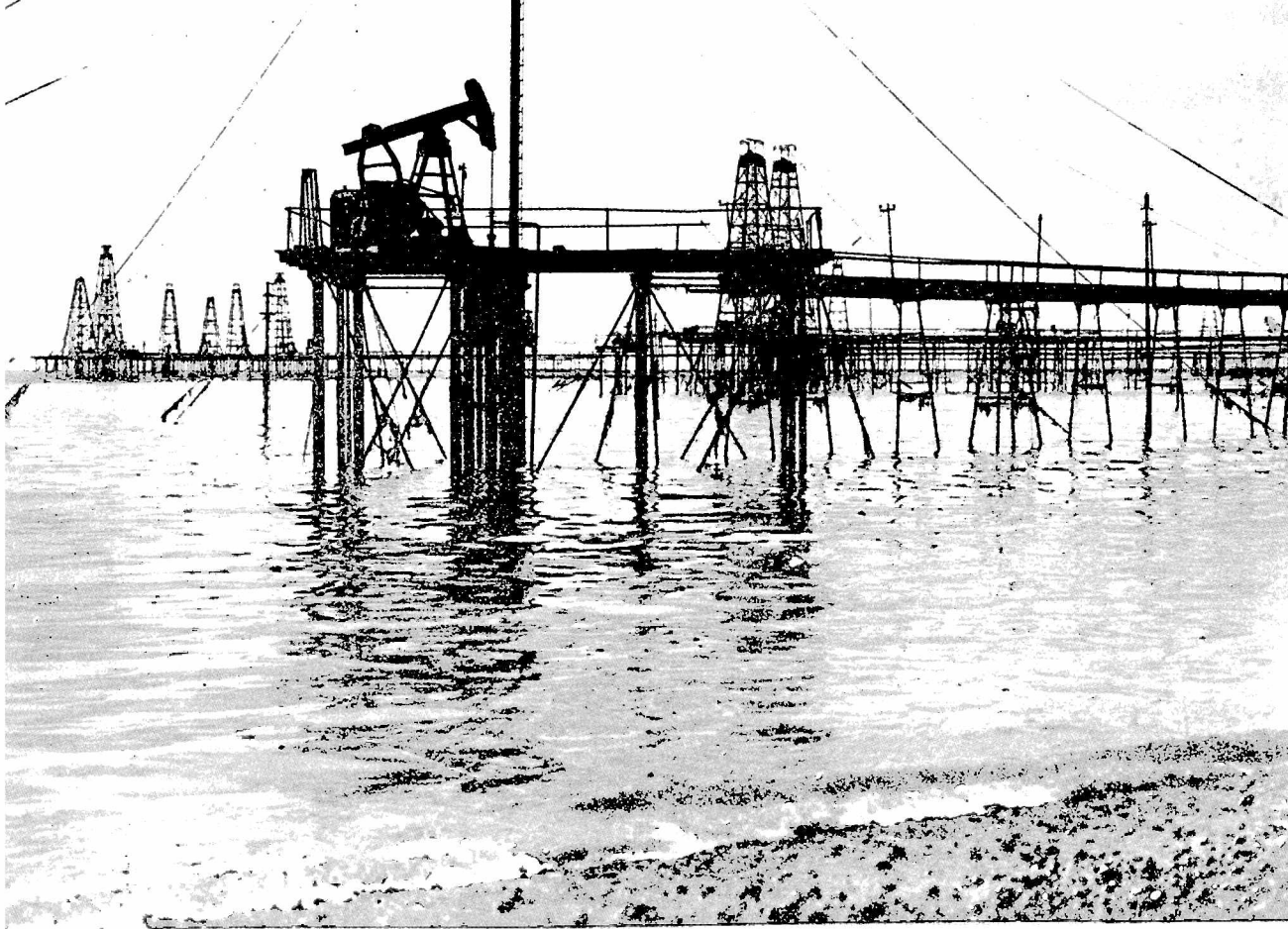
Figura 49. — Pozos de petróleo
