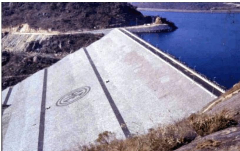
Figura 3. Presa Principal Embalse Cerro Pelado
