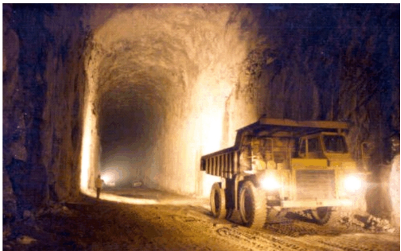
Figura 1. Excavación del Túnel de Restitución
