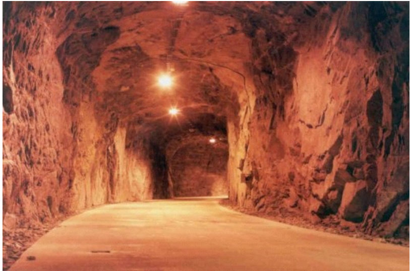
Figura 5. Túnel Carretero de acceso a la Caverna
