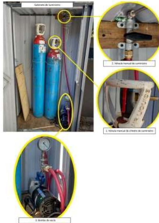
Fig. 47: Gabinete de suministro y sus componentes.
