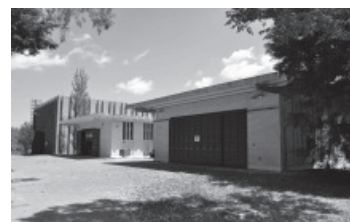
Instalaciones del Área de Gestión Ezeiza Centro Atómico Ezeiza Pcia. de Buenos Aires
