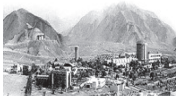
Centro de Investigaciones Atómicas y Reactor de investigación RP-10 construidos por la CNEA en Huarangal - Perú
