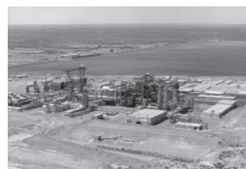
Planta Industrial de Agua Pesada (ENSI S.E.) Arroyito – Pcia. del Neuquén
