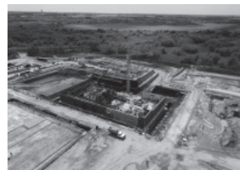
Proyecto Reactor de investigación multipropósito RA -10 (en construcción) Centro Atómico Ezeiza Pcia. de Buenos Aires
