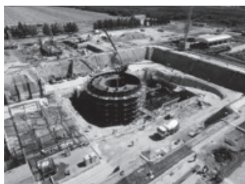
Central nuclear argentina CAREM (en construcción) Lima Pcia. de Buenos Aires
