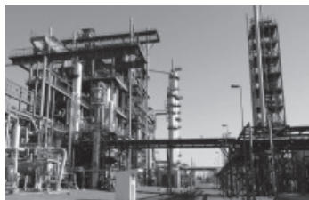
Planta Industrial de Agua Pesada (ENSI S.E.) Arroyito – Pcia. del Neuquén
