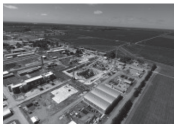
Central Nuclear Argentina CAREM Vista general de las obras Lima - Pcia. de Buenos Aires
