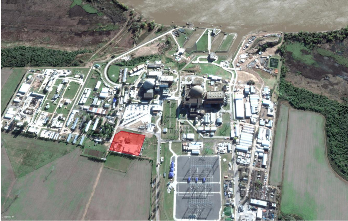
Imagen N°1: Vista aérea del edificio del Simulador de Alcance Total de CNAII
