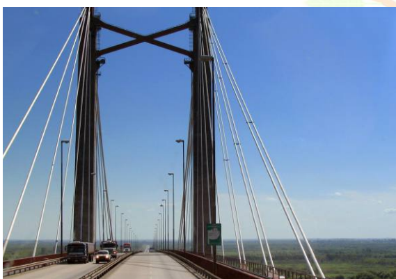
Obenques del complejo ferroviario Zárate-Brazo Largo. Une las provincias de Buenos Aires y Entre Ríos.
