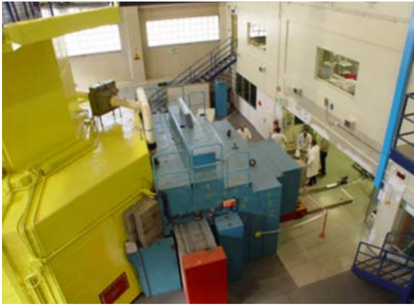
Figura 4.18: Vista superior de la columna térmica del reactor TRIGA.
