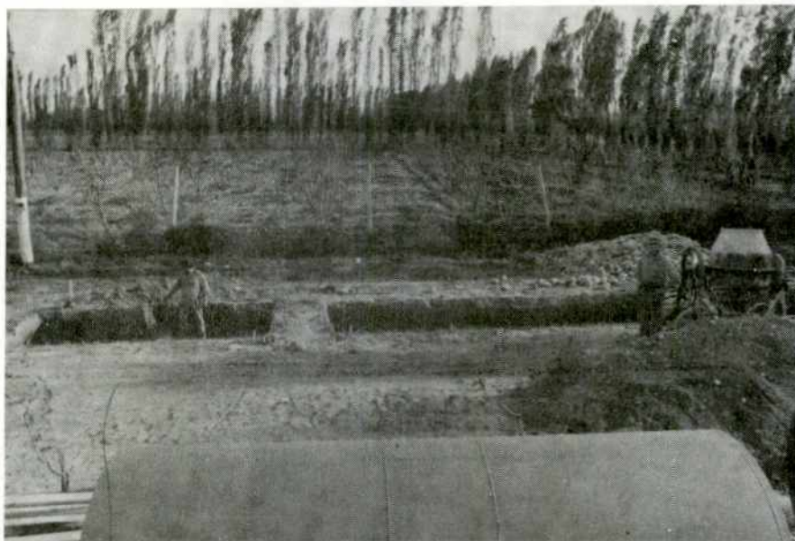
Excavación de Bases
