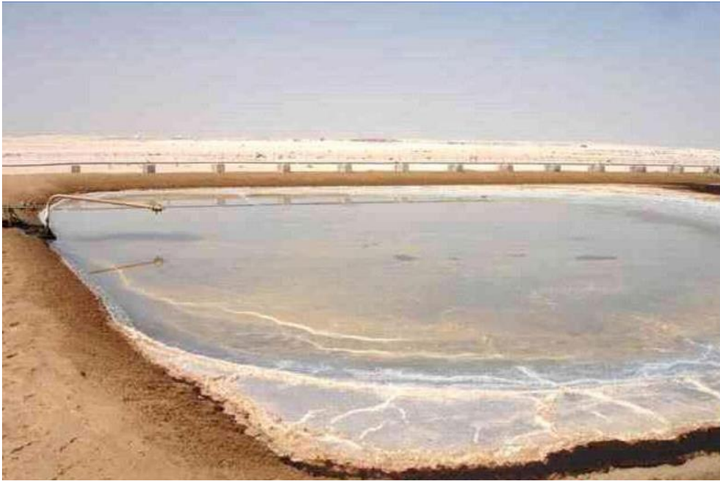
Figura 6. Pasivo ambiental de la industria petrolera. Estanque de evaporación de aguas de formación y aguas residuales que quedan luego de la extracción del petróleo en la que suelen concentrarse en RN pertenecientes a las series naturales de ^{238}\text{U} , ^{235}\text{U} y ^{232}\text{Th} .
