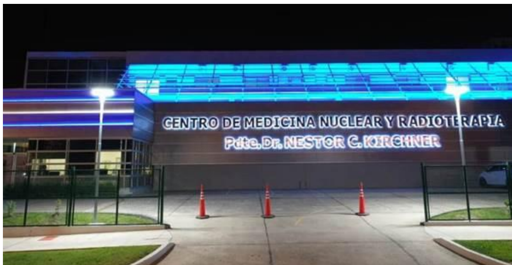
Figura 2.1: Frente del CEMENURNK.
