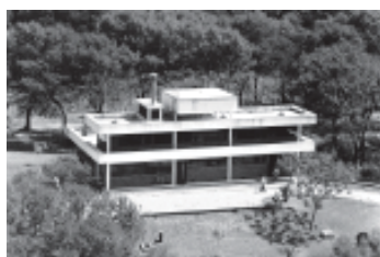
Edificio de acondicionamiento de residuos radiactivos - Área de Gestión Ezeiza
