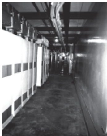
Centro Atómico Ezeiza Planta de Irradiación Semi Industrial
