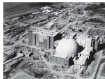
Central Nuclear Atucha II (en construcción)
