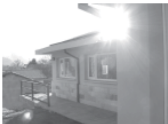
Centro Atómico Bariloche - Edificio de Ingeniería para el Proyecto CAREM
