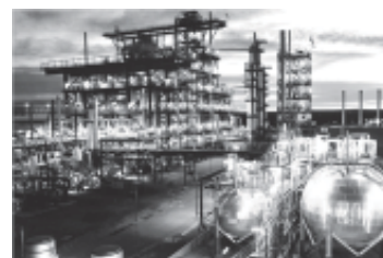
ENSI S.E. Planta Industrial de Agua Pesada Arroyito - Pcia. del Neuquén
