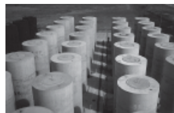
Área temática Seguridad Nuclear y Ambiente - Almacenamiento en silos de combustibles gastados de la Central Nuclear Embalse
