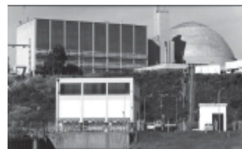
Central Nuclear Atucha I Pcia de Buenos Aires - Vista desde la toma de agua
