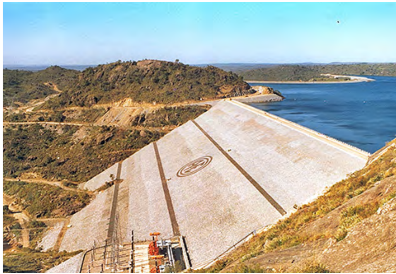
Figura 8: Central Hidroeléctrica Río Grande (Córdoba).
