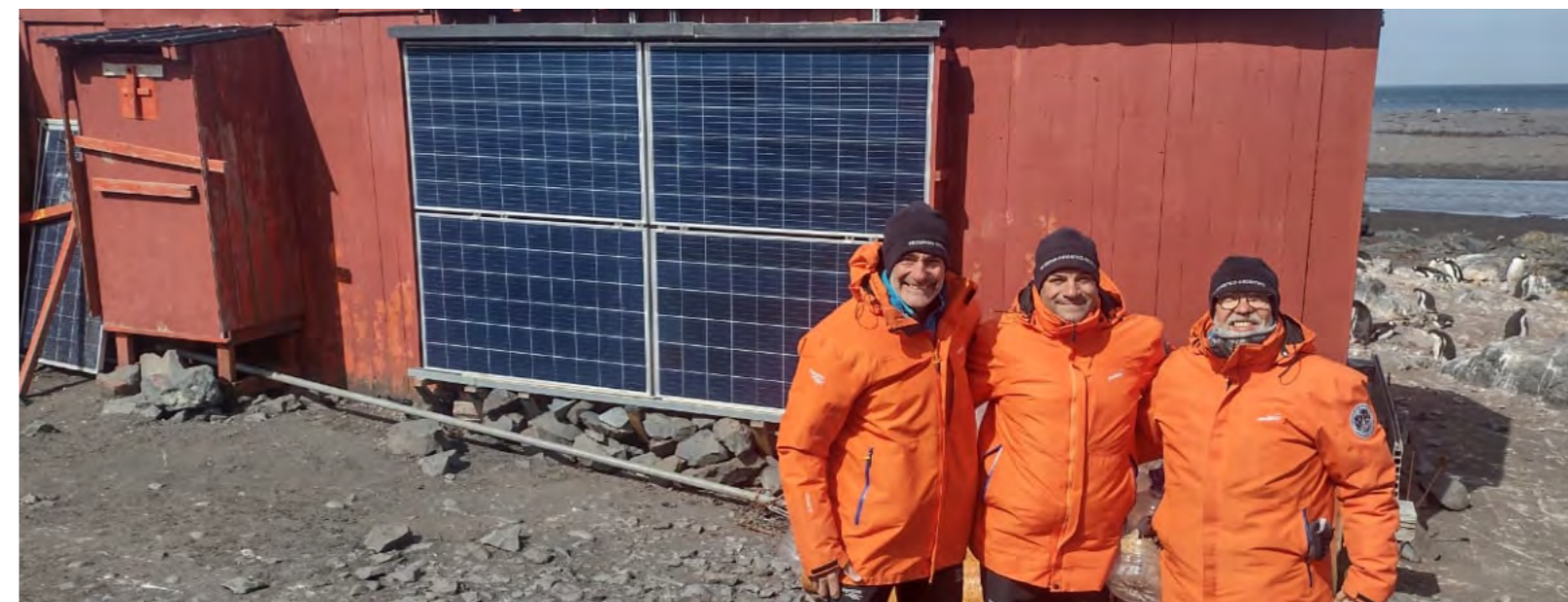
El grupo de trabajo del DES junto a la instalación de paneles solares realizada en el Refugio Elefante en el año 2020.
