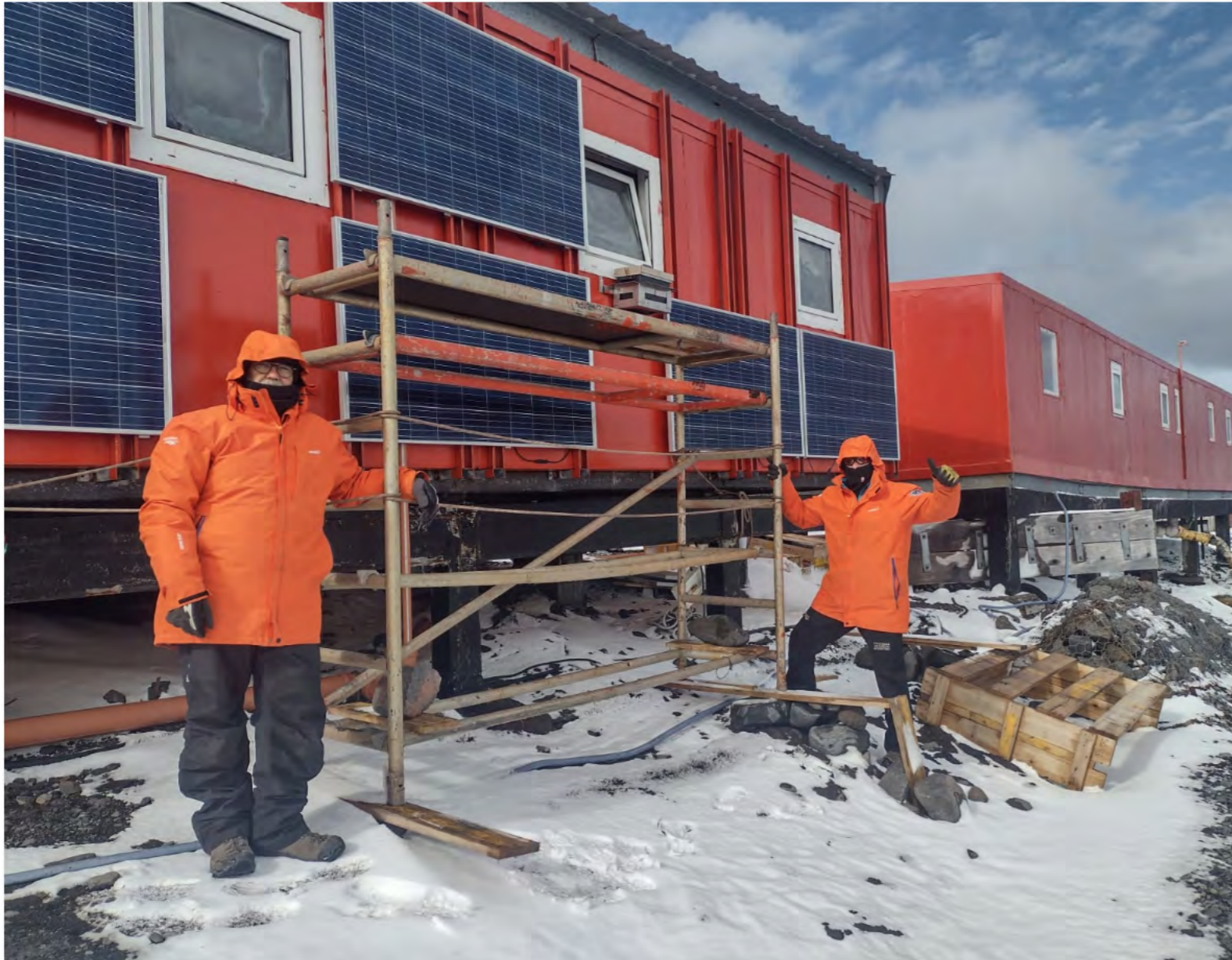
Instalación de paneles solares en la Base Carlini.
