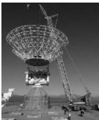
Proyecto DSA-3 Antena de 35 m de diámetro de disco en construcción cerca de Malargüe Pcia. de Mendoza
