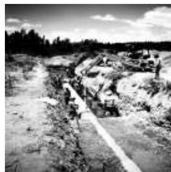
Proyecto Restitución Ambiental de la Minería del Uranio (PRAMU) Sistema de drenaje de aguas superficiales y subterráneas Ex - Complejo Minero Fabril Malargüe Pcia. de Mendoza
