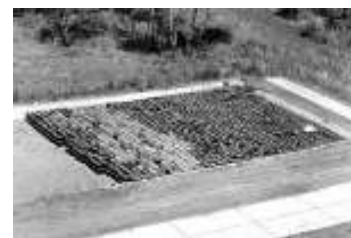
Trinchera para almacenamiento temporal de residuos de baja actividad Área de Gestión Ezeiza Centro Atómico Ezeiza
