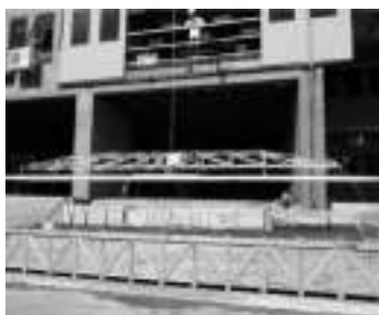
AMIGA Módulo de 10 m 2 en preparación para su traslado en contenedor.
