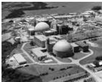
Central Nuclear Atucha I y Central Nuclear Atucha II (en construcción) Lima - Pcia de Buenos Aires
