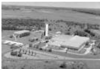
Fábrica de Aleaciones Especiales S.A.(FAE S.A.) Centro Atómico Ezeiza
