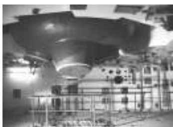
Central Nuclear Atucha II (en construcción) Vista inferior del generador de vapor
