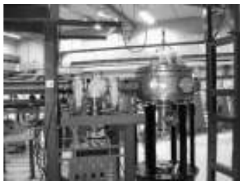
Cámara de irradiación del Acelerador TANDAR Centro Atómico Constituyentes
