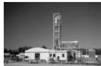
Planta de liofilización construida por INVAP S.E en México
