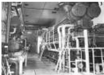
Central Nuclear Atucha II (en construcción) Generadores de emergencia
