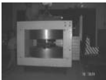
Proyecto Ciclotrón de pié de hospital Montaje piezas polares y bobinas de campo magnético Centro Atómico Ezeiza
