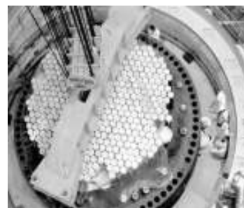
Central Nuclear Atucha II (en construcción) Núcleo del reactor
