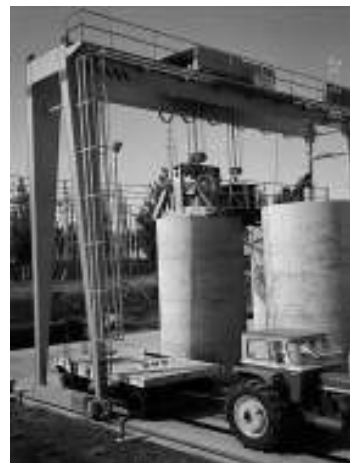
Carga de silos para almacenamiento temporario en seco de combustibles gastados Central Nuclear Embalse
