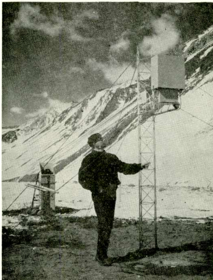
Fig. 22 h. Nivómetro instalado.
