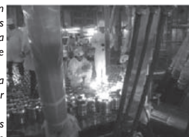
Inspección de la carga de elementos combustibles en el núcleo de la Central Nuclear Atucha II (en construcción)
