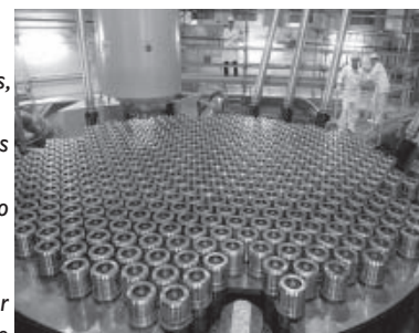
Central Nuclear Atucha II (en construcción) Canales para los elementos combustible
