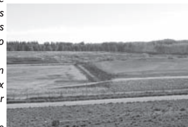
Proyecto PRAMU Trabajos de restitución ambiental Ex - Complejo Minero Fabril Malargüe Pcia. de Mendoza
