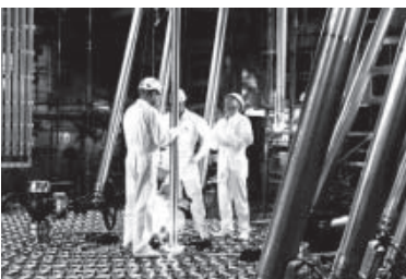
Central Nuclear Atucha II (en construcción) Carga de elementos combustibles Pcia. de Buenos Aires
