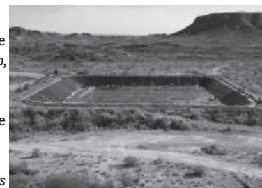
Complejo Minero Fabril San Rafael Reparación del dique pulmón de efluentes ácidos Pcia. de Mendoza
