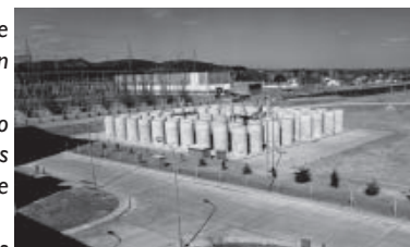
Almacenamiento temporario en silos de elementos combustibles gastados Central Nuclear Embalse
