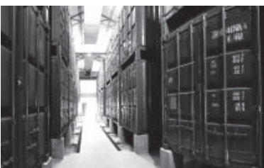
Depósito de Elementos Combustibles Gastados Área de Gestión Ezeiza
