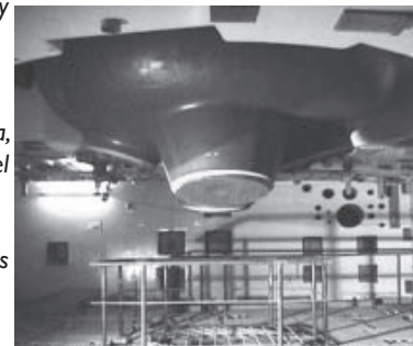
Central Nuclear Atucha II (en construcción) Vista inferior del generador de vapor
