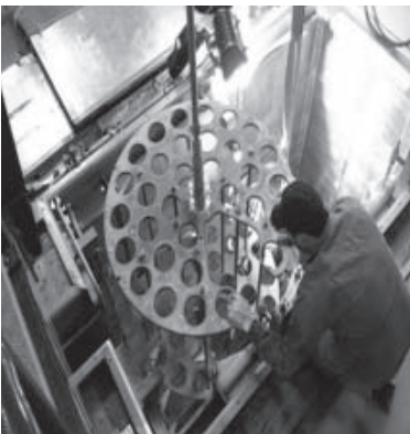
Montaje canastas almacenamiento combustibles irradiados bajo agua en pileta de la ECRI Centro Atómico Constituyentes
