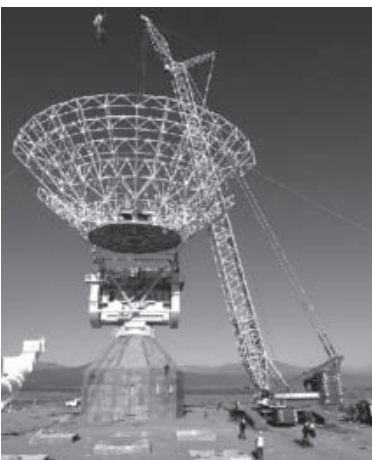
Proyecto DSA-3 Antena de 35 m. de diámetro de disco Malargüe
