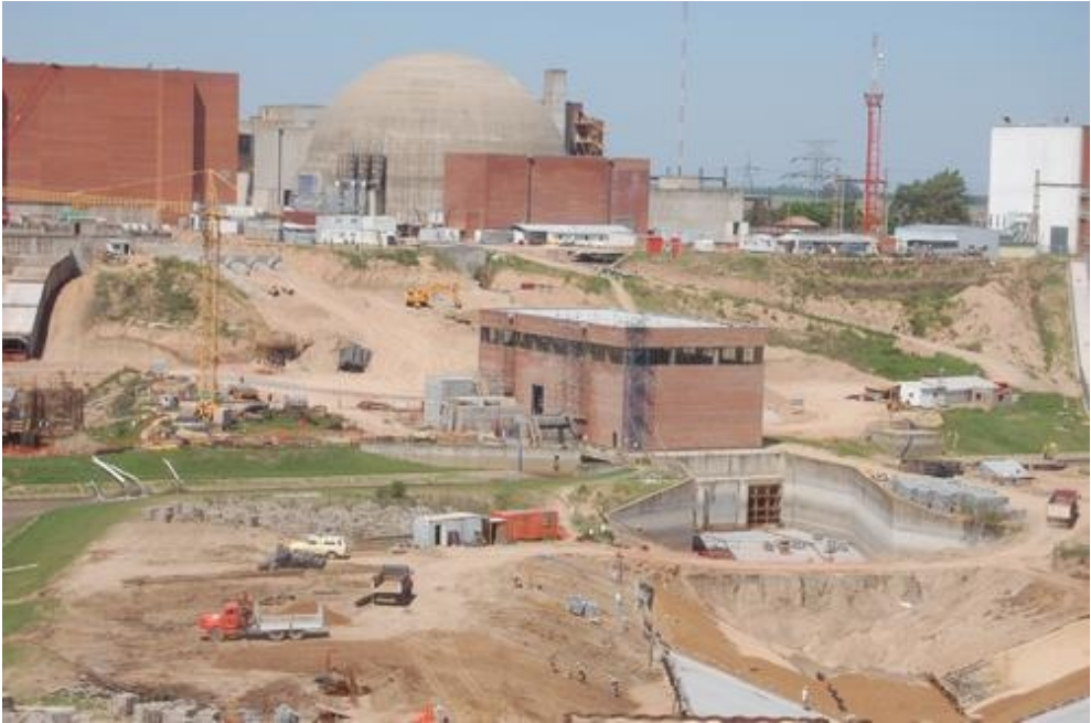
Figura 3. Vista aérea de la construcción de la central nuclear Atucha II 2
