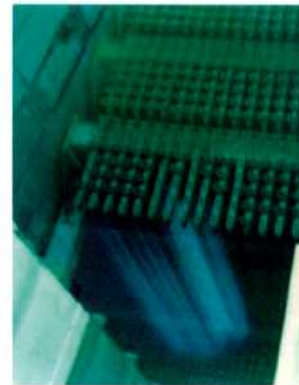
Figura 1.2 Pileta en Central Nuclear Atucha I
