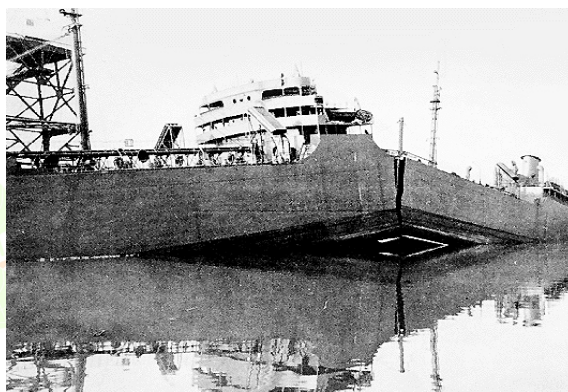
Barco de guerra Tanker -2 USS Schenectady - Un caso clásico de fractura rápida (frágil), acaecida en puerto, estando la nave amarrada y descargada.
